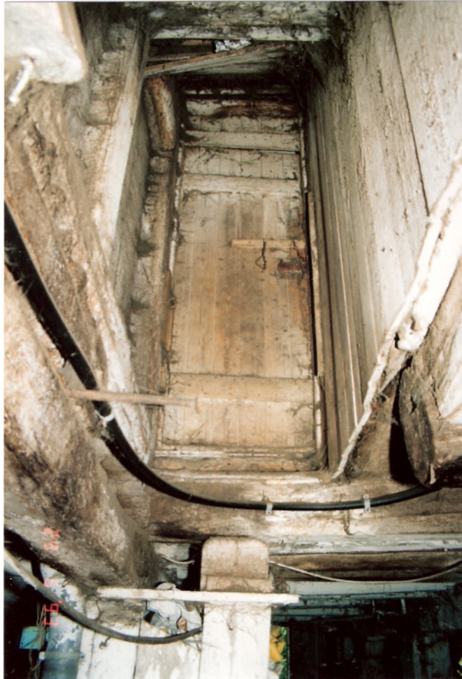
Foto 13: Detail im rückwärtigen Stallbereich, Blickrichtung zur Decke. Ehemalige innenliegende Verbindung zwischen Wohnteil im Obergeschoß und Viehstall im Erdgeschoß. Die Treppe wurde zwischenzeitlich entfernt.
