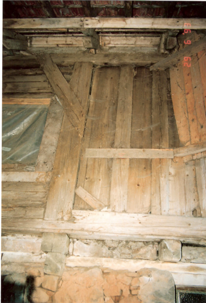
Foto 9: Ausschnitt der rückwärtigen Traufseite mit Blick auf einen Bundständer mit angeblattetem Kopfband und einer liegenden Bohlenwand links, Reste eines Fensterbandes und einer stehenden Bohlenwand rechts, oben Sparrenköpfe.
