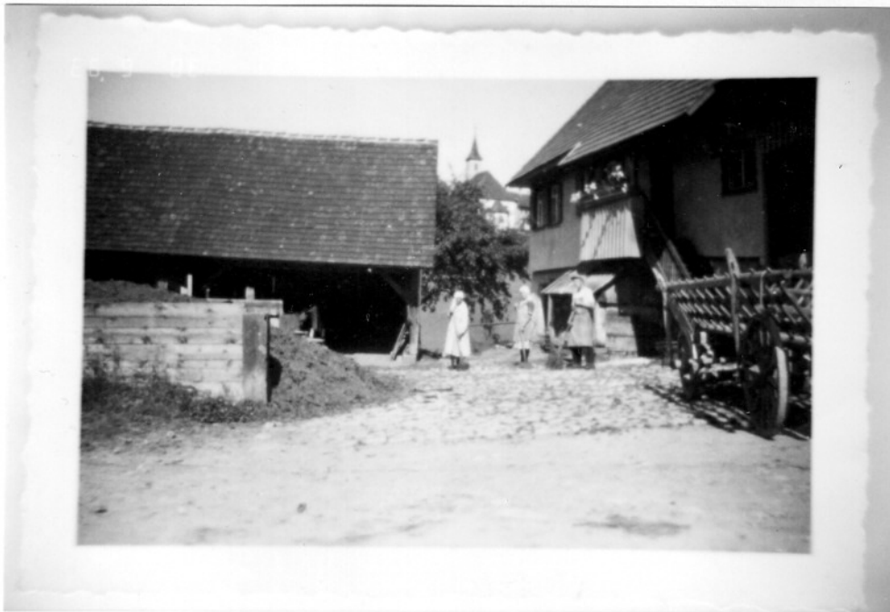
Abb. 4: Die alte Fotografie von 1936 zeigt einen Teil der Südfassade mit Treppenaufgang und dem Schweinestall darunter. Links im Bild der in den Archivalien aufgeführte Holz- und Wagenschuppen.
