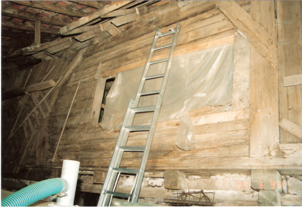
Foto 11: Ausschnitt der nördlichen Rückseite auf Höhe der heutigen Tenne. Die Aussparung zeugt von einem zweifachen Fenster an dieser Stelle, das laut Aussage früherer Bewohner mit Schiebevorrichtung ausgestattet war (vergl. Foto 15).
