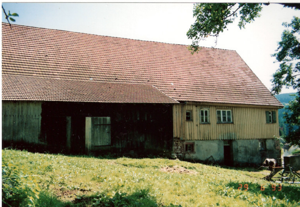
Foto 1: Außenansicht der nördlichen Rückseite. Der Wohnteil rechts ist im Obergeschoß mit Holzdeckleisten verschalt. Der Schuppen vor dem Wirtschaftsbereich links im Bild wurde im Laufe der Zeit immerwieder erneuert.
