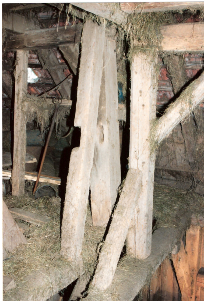
Foto 20: Schnittstelle zwischen Kernbau links und östlichem Anbau rechts, kennzeichnet den ursprünglichen Außenwandabschluß. Während das Konstruktionsgefüge des Kernbaus durch Blattverbindungen (heute abgängig) charakterisiert wird, zeigt der Anbau verzapfte Holzverbindungen.
