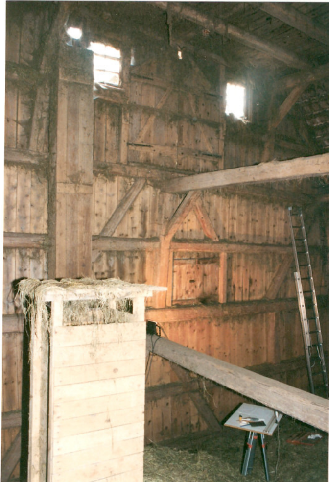
Foto 17: Innenansicht der östlichen Giebelseite, die den offenen Bergeraum des Ökonomiebereichs abschließt. Der Wirtschaftsteil wurde 1707 ff. erweitert. Gleichzeitig wurden Veränderungen im Erdgeschoßbereich vorgenommen.
