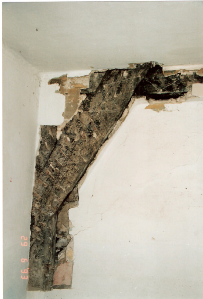
Foto 27: Detail des freigelegten Ständers mit angeblattetem Kopfband in der Küche (Foto 26). An der Holzkonstruktion lassen sich die Rußschwärzungen der ehemaligen Rauchküche ablesen.
