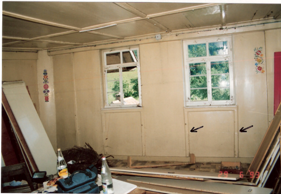
Foto 21: Die ehemalige Stube des Hauses mit Blickrichtung nach Süden. Eine Einkerbung an den Zierleisten der Wandvertäfelung, die aus der letzten Ausbauphase als bewohntes bäuerliches Anwesen stammt, erinnert an die zwischenzeitlich entfernte, umlaufende Sitzbank.
