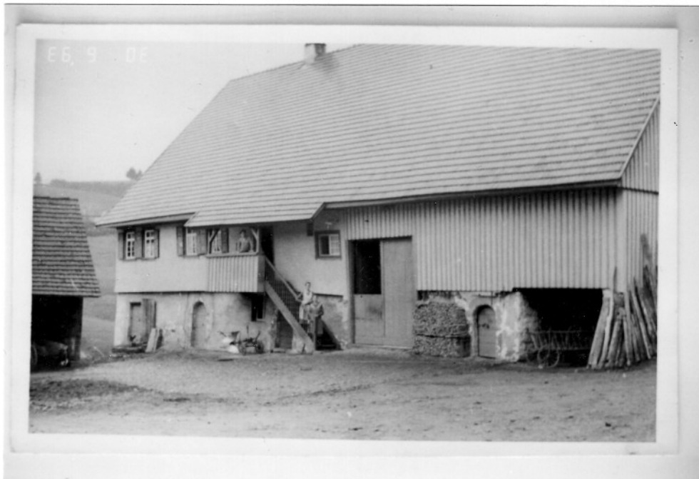
Abb. 5: Auf dem undatierten Foto ist die Südfassade des Althaushofes erkennbar. Hier wurde der Schweinestall bereits entfernt und nach innen verlegt. Der Rundbogeneingang rechts im Bild wurde inzwischen durch eine größere Wandöffnung ersetzt. Am oberen Bildrand bemerkt man den Schornstein, der zwischenzeitlich ebenfalls abgebrochen wurde.
