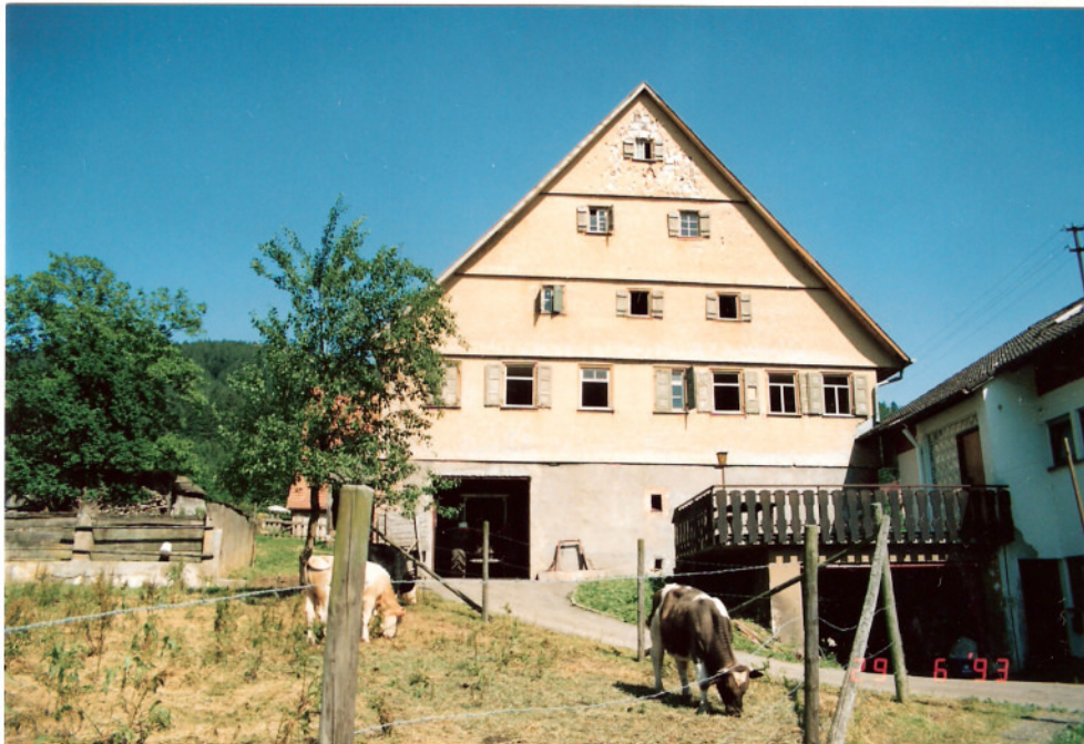
Foto 3: Außenansicht der westlichen Giebelfassade mit Schindelabdeckung und geschosswise Auskrägung.
