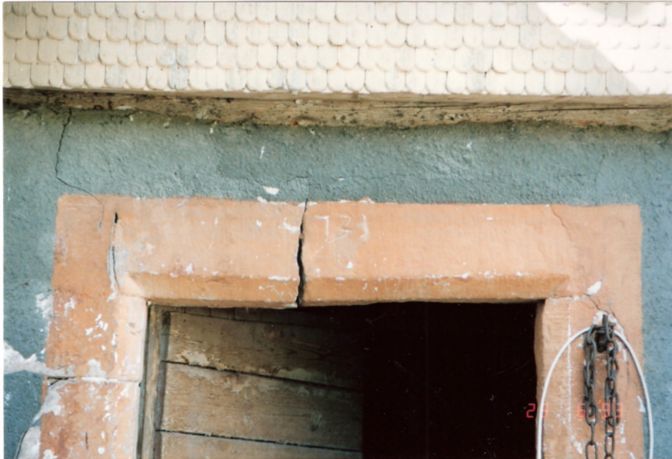
Foto 5: Detail der südlichen Außenseite (vergl. Titelfoto), Erweiterungsanbau von 1773 ff.. Ebenerdig führt ein Eingang mit geradem Sturz in die Kleintierställe des Erdgeschosses. Unstimmigkeiten im Sockelbereich könnten auf Zweitverwendung hindeuten.
