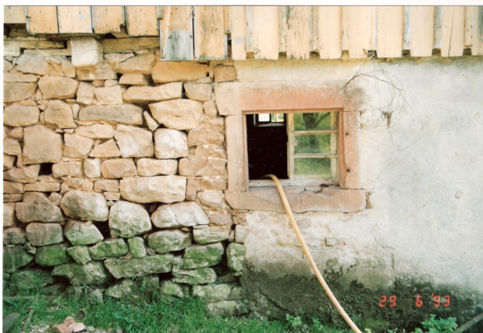
Foto 2: Detail der nördlichen Außenseite im Erdgeschoßbereich. Es zeigt ein annähernd quadratisches Stallfenster mit Sandsteingewände. Die saubere Putzkante erinnert noch an den abgängigen Abortanbau. Offensichtlich war lediglich die rechte Gebäudehälfte im Sockelgeschoß verputzt.
