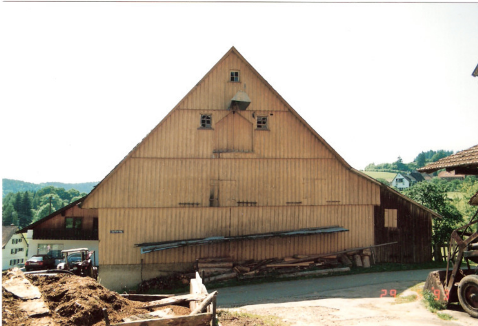
Foto 4: Außenansicht der östlichen Giebelseite. Hinter der mit Holzdeckleisten verschalteten Fassade mit verschiedenen Ladeluken befindet sich der Ökonomieteil.
