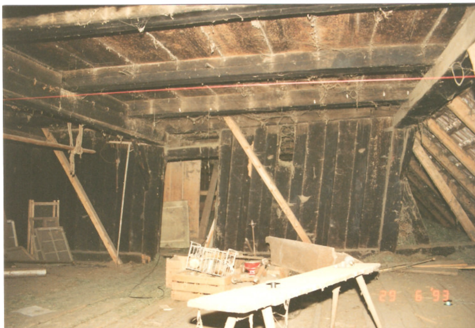
Foto 32: Der westliche Dachgeschoßbereich ist durch Bohlenwände in einzelne Kammern unterteilt. Das Gefüge weist starke Verformungen auf. Dierußgeschwärzte Holzkonstruktion belegt das ursprünglich offene Rauchdach des Kernbaus. Die weiten Abstände zwischen den Kehlbalken deuten auf eine leichte Dachbedeckung des Ursprungsbaus.
