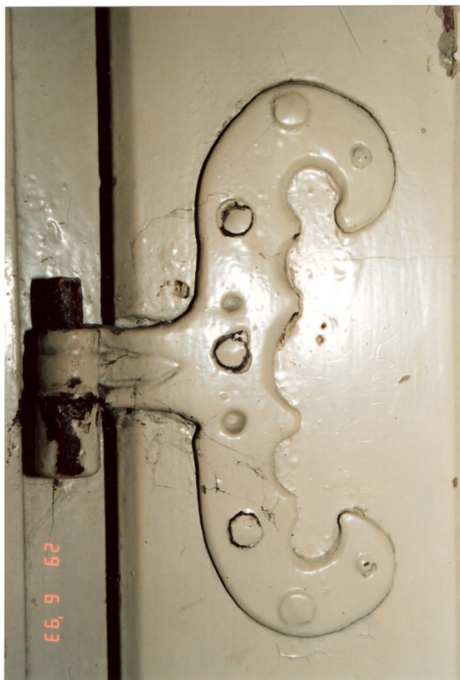
Foto 29: Geschwungenes Beschlagdetail des Türblatts zwischen Küche und Stube .
