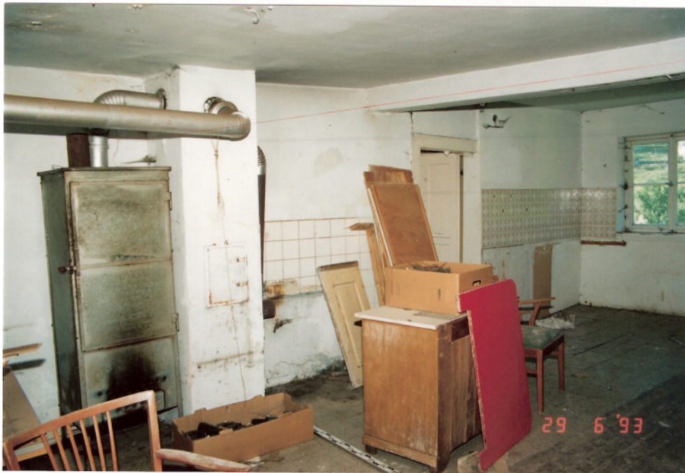
Foto 23: Westlicher Küchenbereich mit nachträglich eingebautem Kamin und Räucherschrank links im Bild.
