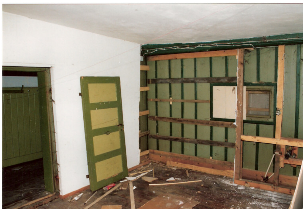
Foto 31: Blick in die vordere Kammer östlich des Hausflurs im Obergeschoß. Hinter der modernen Vorsatzschalung blieb eine ältere Holzvertäfelung an den Wänden erhalten.
