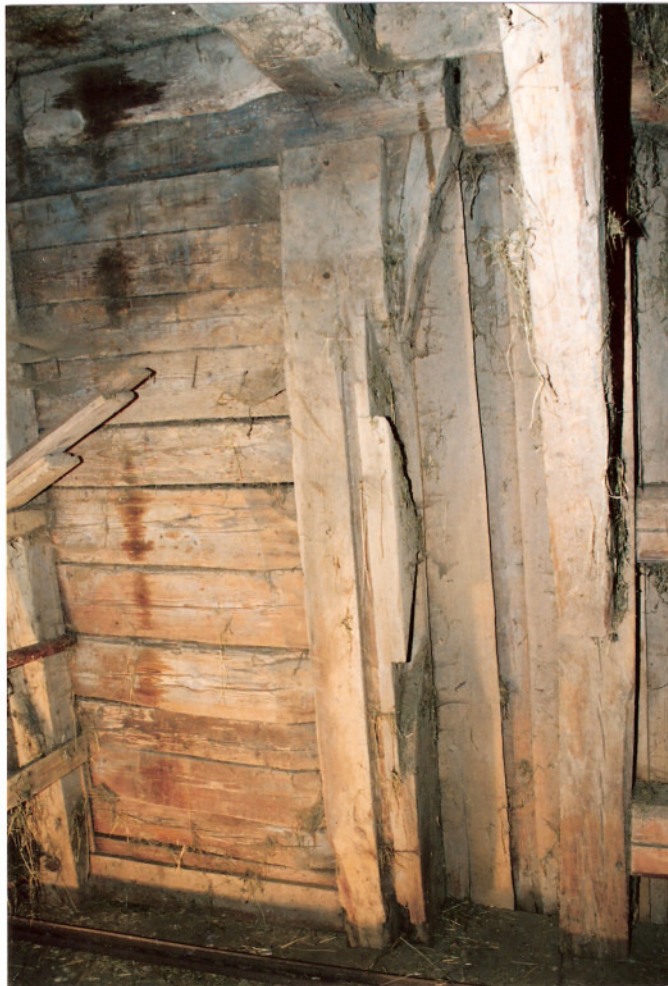
Foto 16: Detail an der nördlichen Innenwand. Abgebildet ist der nordöstliche Eckständer der ursprünglichen Giebelfassade des Kernbaus (Knagge rechts oben und Blattsitze für die ehemalige Verstrebung vorhanden), links im Bild liegende Bohlenwand. Die durchgehende Nut läßt auf das Einschieben einer Bohlenwand schließen, die zu eine Kammer des Hauses abschloß und erst nachträglich zur Tenne umgebaut wurde.
