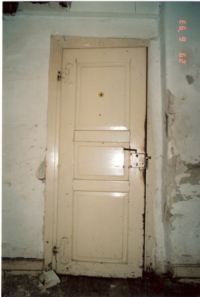
Foto 28: Alte Dreifüllungstür in der Südwand der Küche zur angrenzenden Stube.
