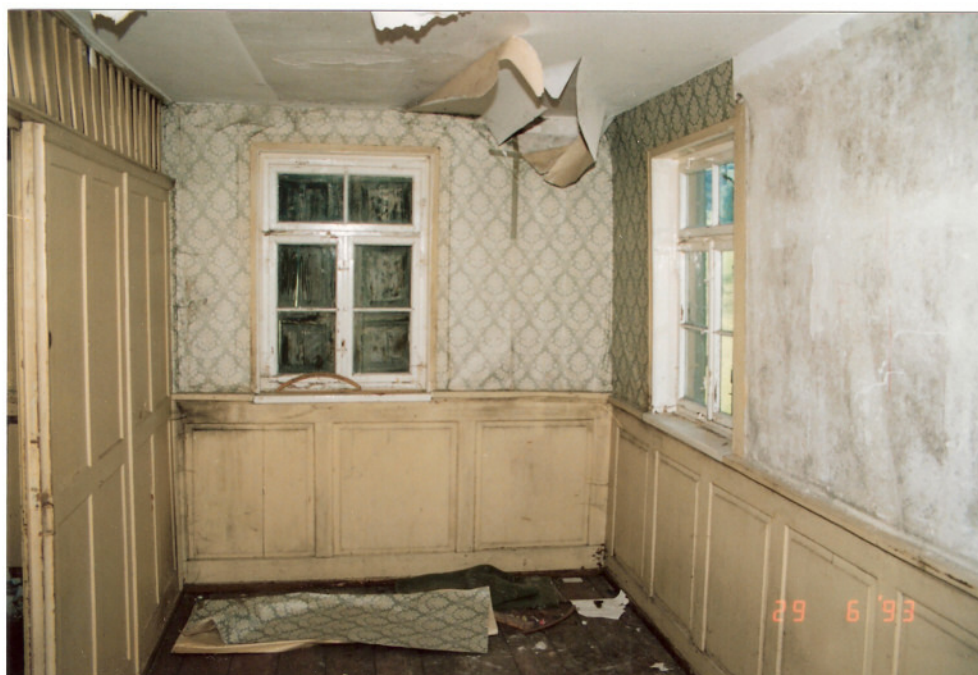
Foto 30: Blick in die hintere Kammer des westlichen Erweiterungsbaus mit umlaufender Lamserie. Dieser Wohnbereich wurde früher als Altenteil genutzt.
