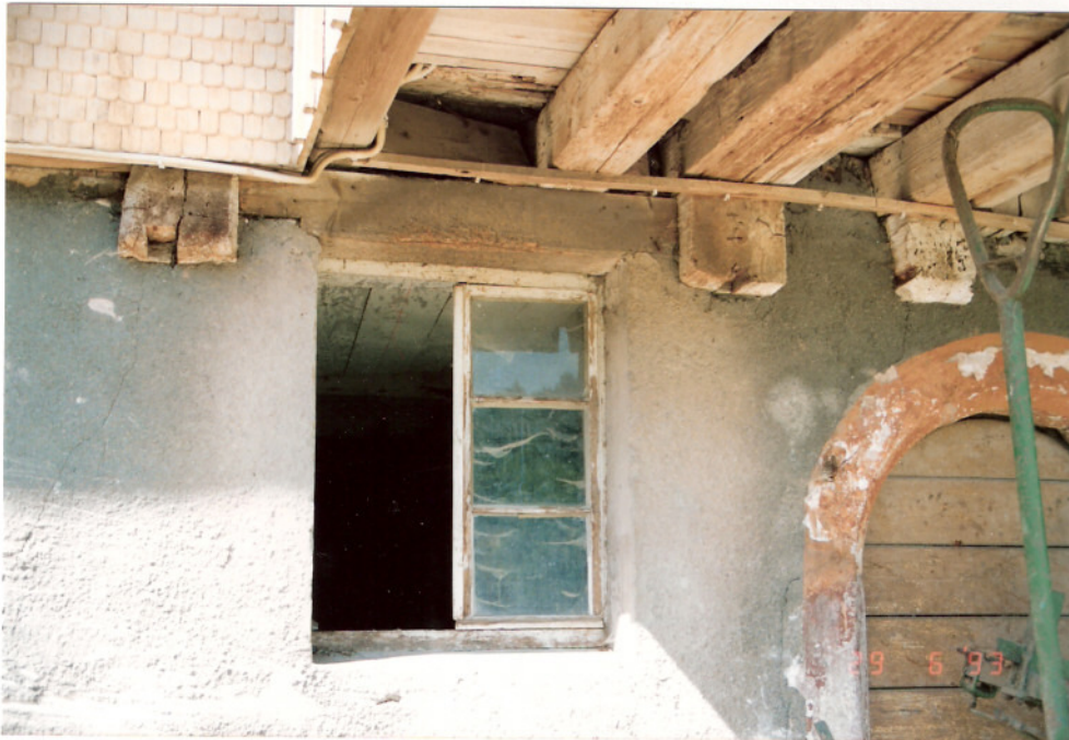
Foto 7: Detail der Südseite, unterhalb des außenliegenden Treppenaufgangs. Die außen sichtbaren Balkenköpfe gehören zum originären Bestand des Kernbaus.
