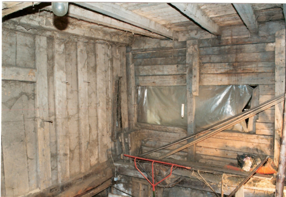
Foto 15: Rückwärtiger Teilbereich der heutigen Tenne mit der Aussparung für ein ehemals eingebautes Zweifachfenster mit Schiebevorrichtung (vergl. Foto 11). Der Türsturz in der Bohlenwand links unterstützt die Annahme, daß sich hier ehemals eine Kammer an den Wohnteil anschloß.
