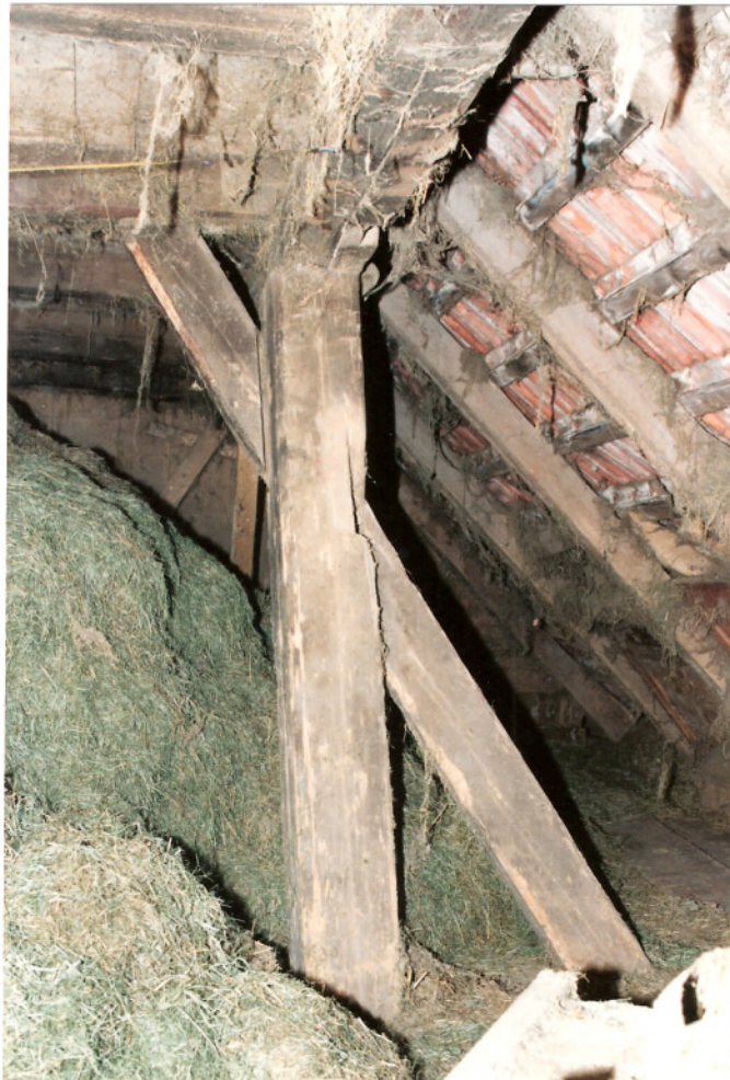
Foto 19: Blick ins Dachgeschoß. Ein Ständer der ursprünglichen Holzkonstruktion des Kernbaus, der durch angeblattete Kopfbänder in Längsrichtung (hier abgängig), sowie durch Quersteigbänder ausgesteift wird.
