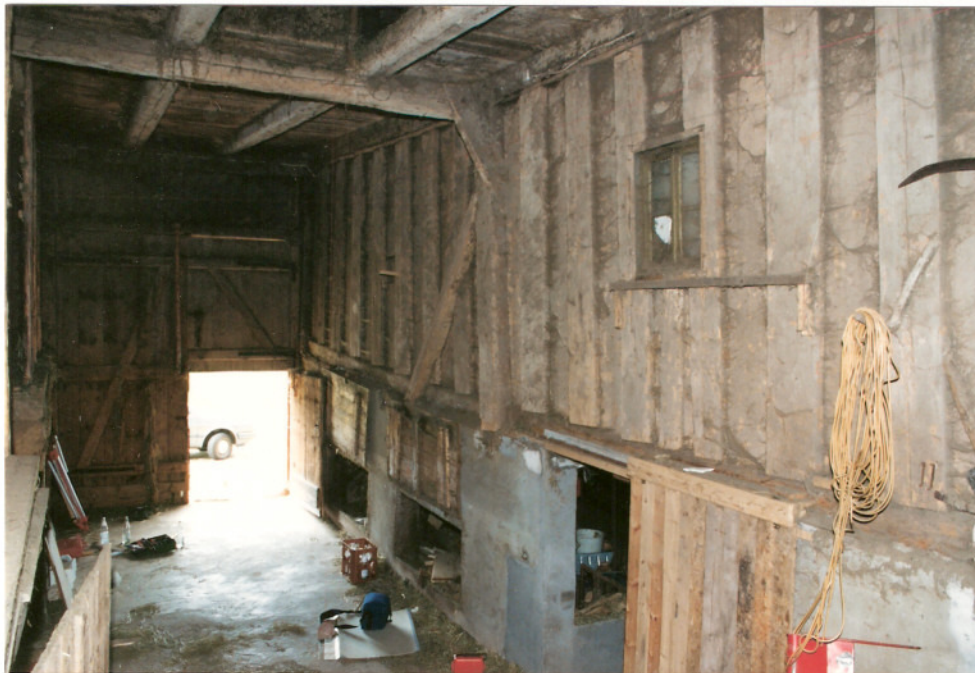
Foto 14: Innenansicht der heutigen Tenne mit Blickrichtung nach Süden. Rechts im Bild ein Fenster in der Bohlenwand, die heute den Wohnteil vom Wirtschaftsbereich trennt.
