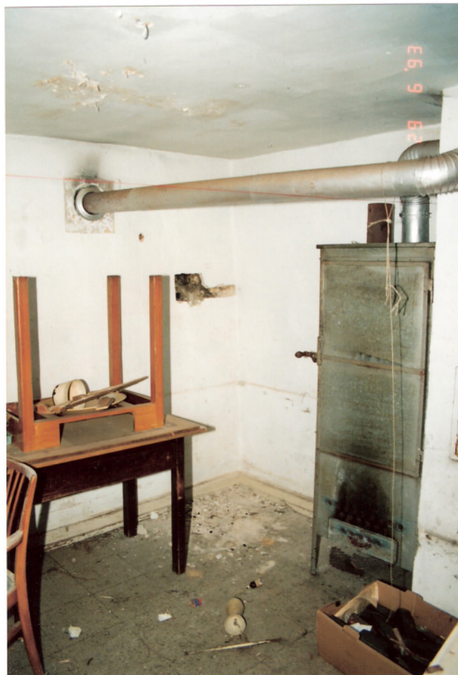
Foto 25: Südwestecke der Küche. An dieser Stelle befand sich noch in den 20er-Jahren dieses Jhs. ein offener Rauchfang, der mit dem Einbau des Kamins überflüssig wurde.
