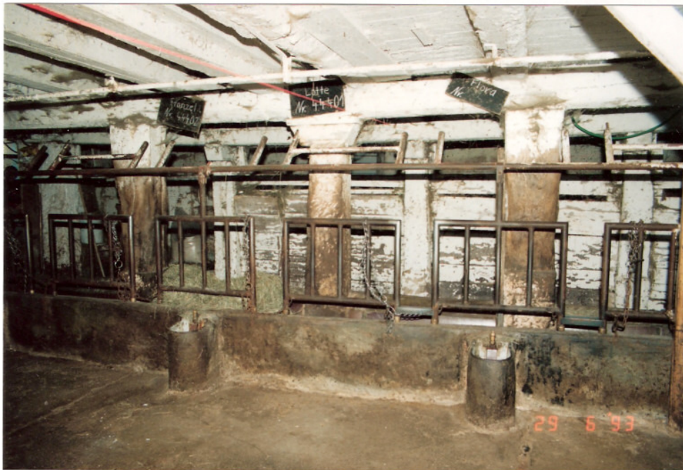
Foto 12: Viehstall im Erdgschoß unter dem Wohnteil mit Blickrichtung nach Osten. Massive Holzsäulen auf Sandsteinsockel stützen den Unterzug.
